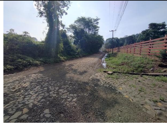
Início da Estrada Municipal RA 475 –Latitude 26°56'21.49"S – Longitude 51° 7'1.94"O Trecho com drenagem insuficiente, tendo acúmulo de água em decorrências das chuvas.
