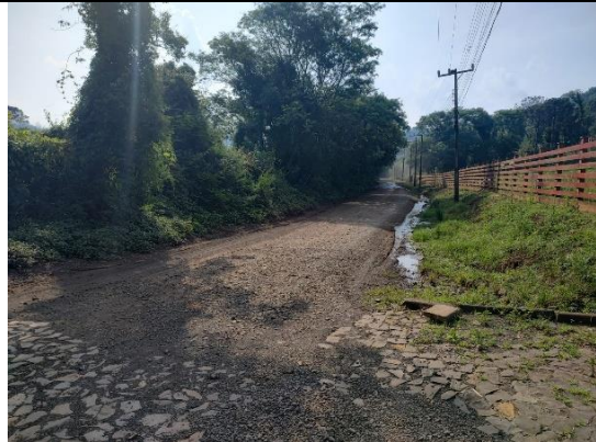
Início da Estrada Municipal RA 475 –Latitude 26°56'21.49"S – Longitude 51° 7'1.94"O Trecho com drenagem insuficiente, tendo acúmulo de água em decorrências das chuvas.
