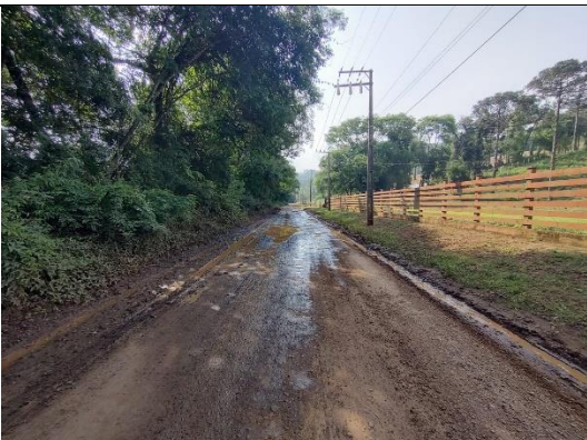
Trecho da RA 475 com presença de solo saturado e com falhas de escoamento pluvial- Latitude 26°56'20.09"S – Longitude 51° 7'4.29"O
