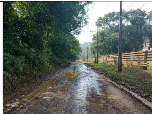
Trecho da RA 475 com presença de solo saturado e com falhas de escoamento pluvial- Latitude 26°56'20.09"S – Longitude 51° 7'4.29"O
