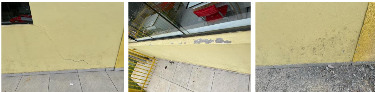
Exemplificação das superfícies que necessitam de preparo/tratamento
