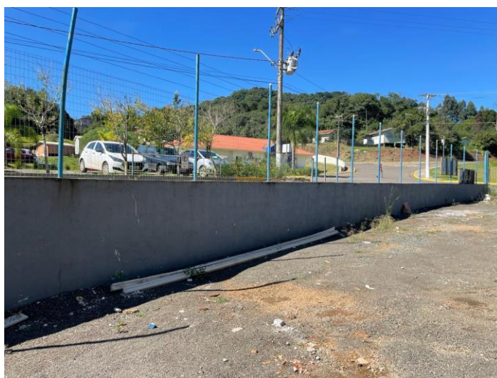
Muro lateral - área líquida alvenaria: 140,94 m 2
