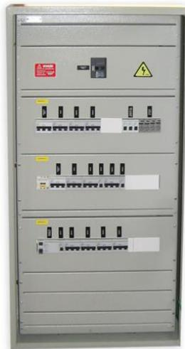
Os Painéis de Baixa Tensão das edificações, deverão ser em armários autoportantes ou caixas de embutir/sobrepôr, com fabricação em chapa metálica, PVC ou Policarbonato, com dimensões suficientes para instalação dos cabos, barras e disjuntores, dependendo das dimensões:
