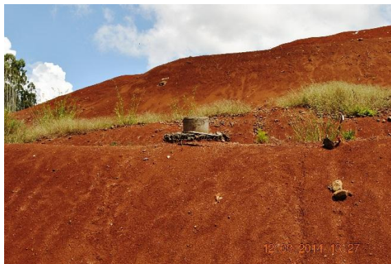
Figura 47 – Dreno vertical do gás existente nas células do aterro sanitário.
