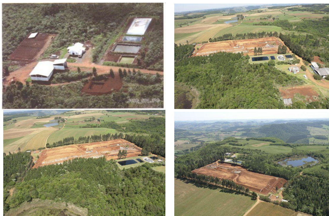
Figura 51 – Aterro Sanitário da empresa T.O.S
