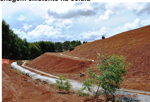
Figura 44 - Sistema de drenagem existente na célula
